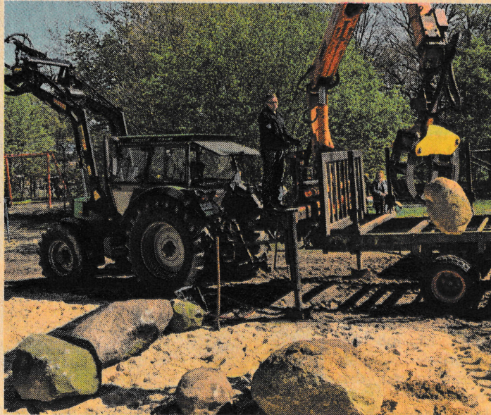
Schweres Gerät musste eingesetzt werden Foto: Plage
